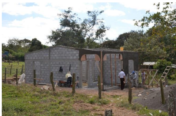
Huis in aanbouw in 2016
