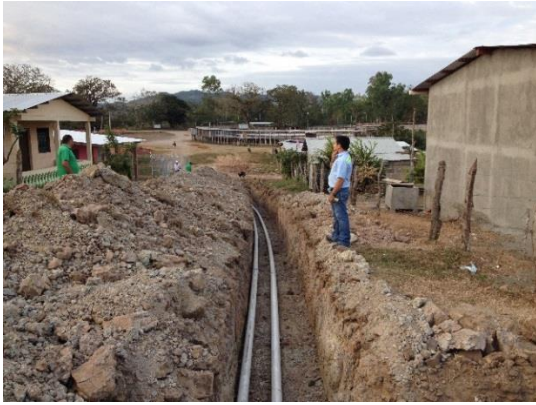
Aanleg pijpleidingen voor waterdistributie
