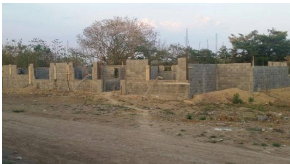
Fase I in aanbouw
