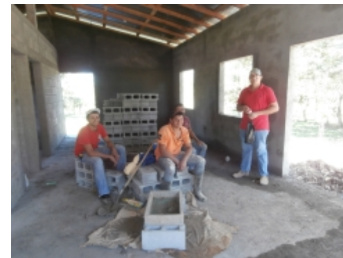
even pauze voor de bouwploeg
